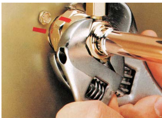
Donner ¼ de tour suppl. à l'écrou-raccord
