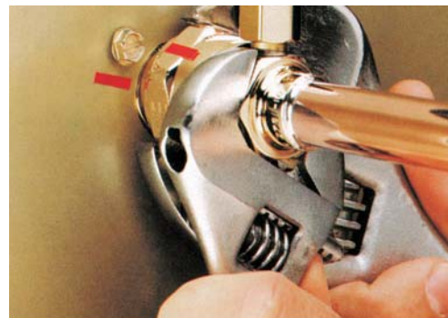
Überwurfmutter um eine weitere ¼ Umdrehung drehen
