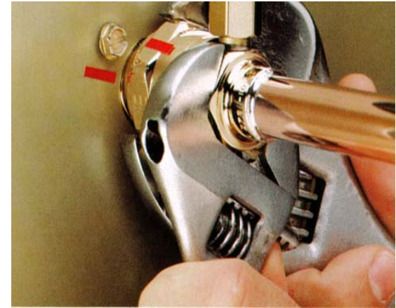
Faire une rotation complète avec l'écrou tournant Suivi d'un quart de tour additionnel L'écrou devient serré
