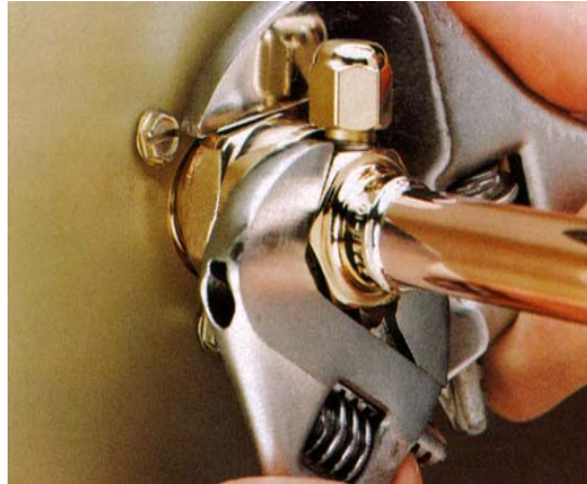
Utiliser deux clés pour serrer
