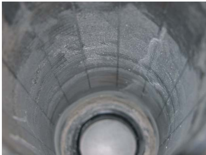
Ejemplo de acumulación de incrustaciones en la pared del evaporador
